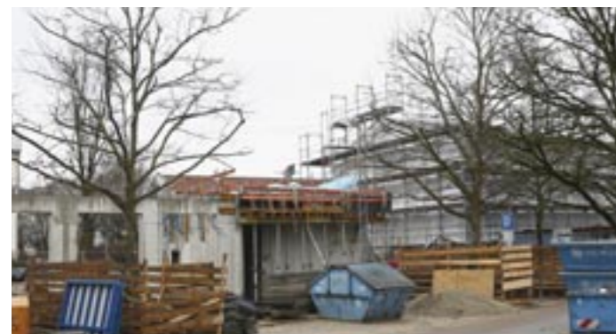
Der Neubau von VHS/Familienzentrum geht gut voran und soll gegen Ende des Jahres eröffnet werden.
